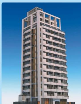
因建造成本提高一倍多，重建委員會接受沈建築師建議取消外牆鋁包板設計，此為修改後外觀圖。
