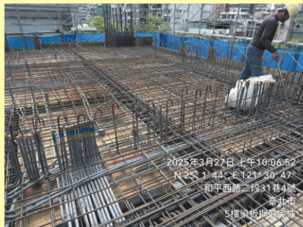
▲ 114年3月27日五樓版鋼筋及水電管線鋪設完成
