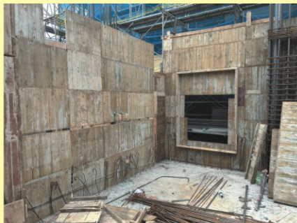
▲ 114年4月9日五樓柱和牆外模板施作
